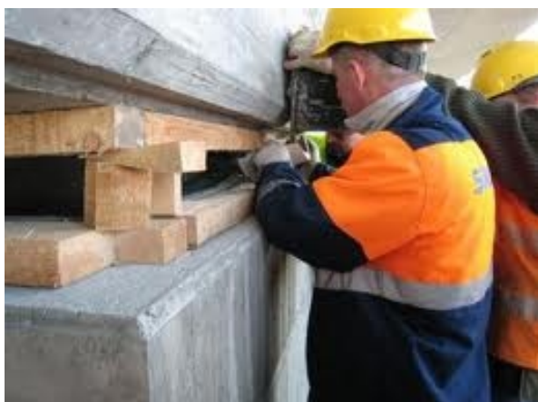
PROIECT : MONTAJ APARATE REAZEM DIN NEOPREN ARMAT DN 6
