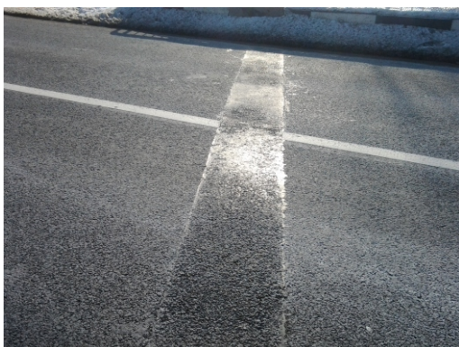
PROIECT : DN 66 BARU - HATEG, POD KM 161+275 EXECUTIE DISPOZITIV ACOPERIRE ROST TIP HIDROPOD (VIAJOINT)
