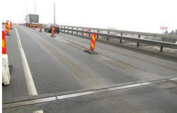
PROIECT : PASAJ CHITILA - MOGOSOIA, BUCURESTI MONTAJ DISPOZITIVE GUMBA TIP BJ50, Bj75, Bj100, BJ230
