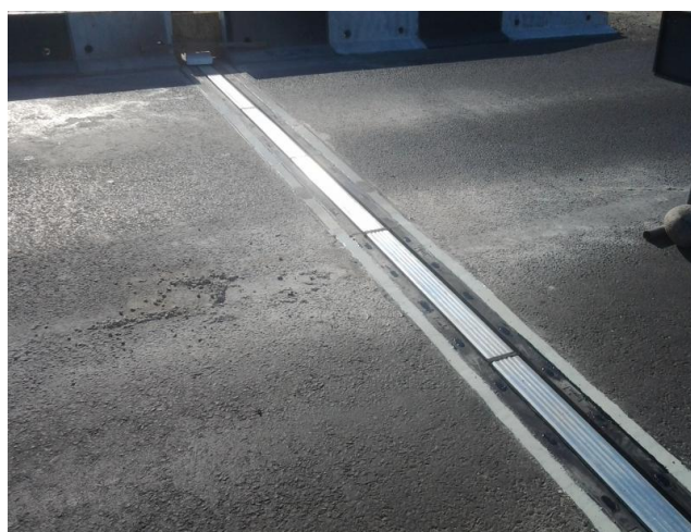
PROIECT : REABILITARE DN2 FOCSANI - ADJUD
