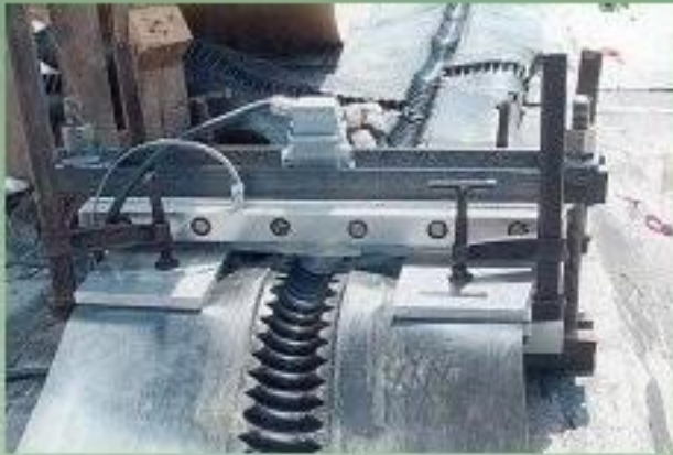
Proces de vulcanizare (îmbinare cap la cap pe șantier).
