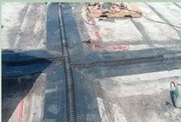
Sistem finalizat (matrița semifabricată împreună cu vulcanizarea îmbinării cap la cap pe șantier) înainte de realizarea etanșării suprafețelor
